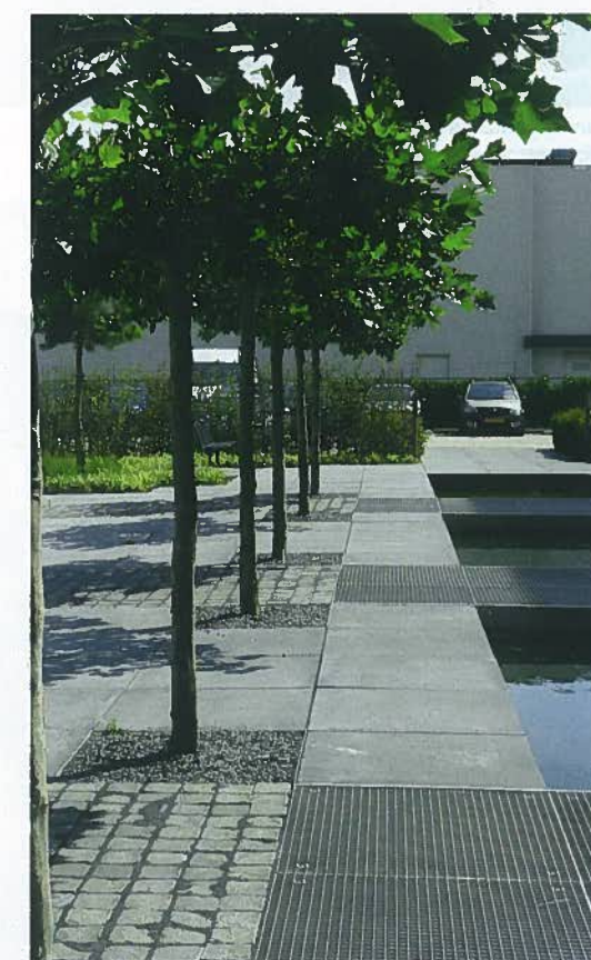
Vier soorten verharding zijn in de tuin toegepast: de basis bestaat uit 1 bij 1 m oud-Hollandse Schellevis betontegels. De drie dwarsbanen bestaan uit basaltkeien en metalen roosters en de boomspiegels zijn afgedekt met Ardener split.
